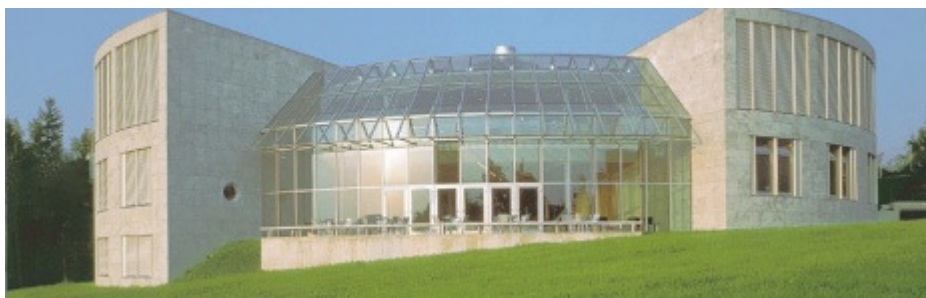
Verklärung statt Aufklärung: Bibliotheksgebäude Universität St. Gallen.
